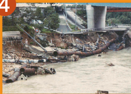
平成16年台風23号 武庫川生瀬橋付近
