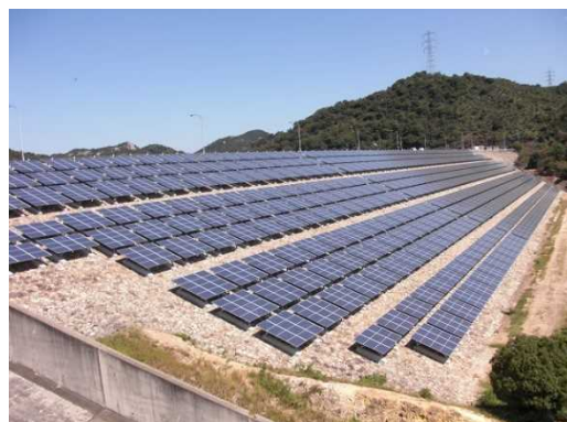
【権現ダム堤体法面】
