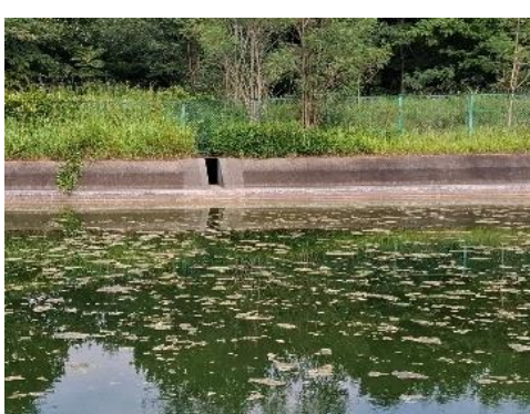
⑥沈砂池 3 放流施設
