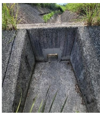
④沈砂池 2 放流施設
