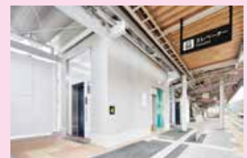
鉄道駅舎エレベーター設置
