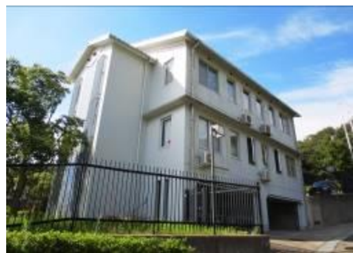
淡路食肉衛生検査所
