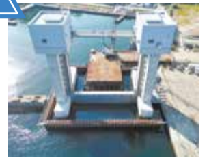
本港地区港口水門の施工状況(昨年11月)
