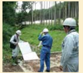
治山施設の点検
