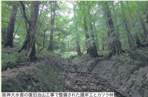
阪神大水害の復旧治山工事で整備された護岸工とカツラ林
