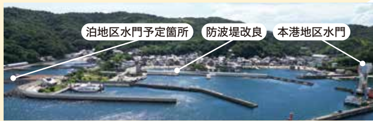
沼島漁港水門、防波堤など
