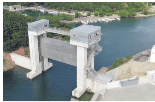
水門の高さは約30m、扉の高さは約9.3m。最大約6mの津波に備えます。
