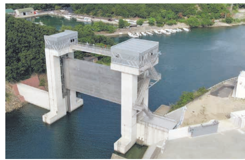
水門の高さは約30m、扉の高さは約9.3m。最大約6mの津波に備えます。
