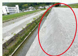
水路に鉄鋼スラグを被せて防除
