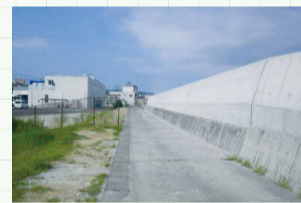
防潮堤かさ上げ(淡路市富島)
