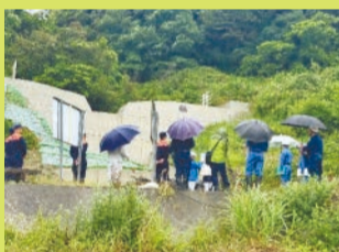
治山施設の点検
