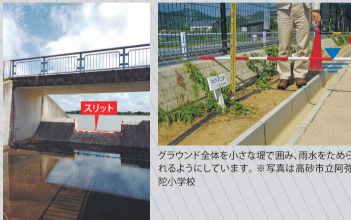
一部のため池では洪水吐(こうずいばき)にスリット(切り欠き)を設け、大雨時の流出量を調節しています。※写真は加古大池(稲美町)
