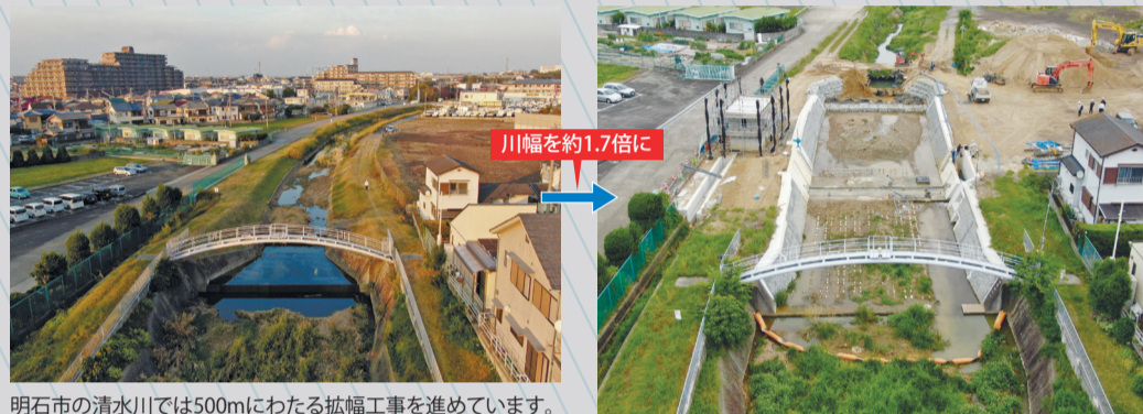
明石市の清水川では500mにわたる拡幅工事を進めています。
