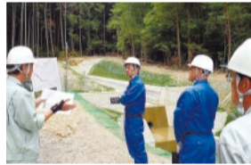
福祉施設隣接災害箇所の点検
