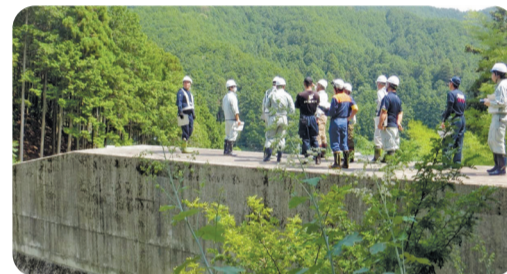
2014(平成26)年の豪雨災害時に土砂が流出した 上ノカチ山に整備された砂防えん堤で、現状を確認。
