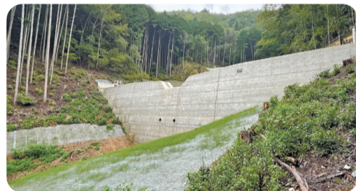
丹波篠山市内に新設された治山ダム。
