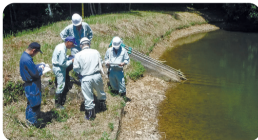
「豊かなむらを災害から守る月間」に合わせ、破損や漏水 がないかなど、ため池をチェック。
