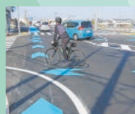
矢羽根型路面表示 の整備
