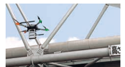
水管橋のエックス線点検
