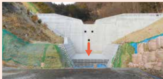
雨森山南谷川砂防えん堤(猪名川町)
