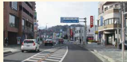
無電柱化の事例
