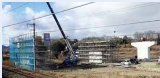
橋脚工事の状況(三田市)
