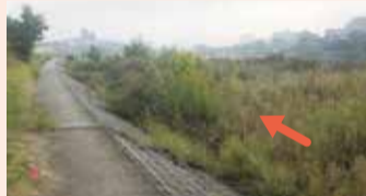
武庫川 土砂撤去工事(宝塚市)
