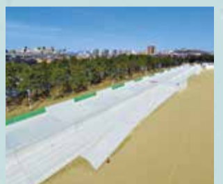
工事が完了した南芦屋浜ビーチ護岸
