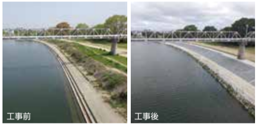
武庫川護岸拡幅工事
