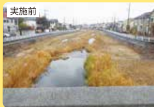
仁川:堆積土砂撤去(西宮市仁川町)
