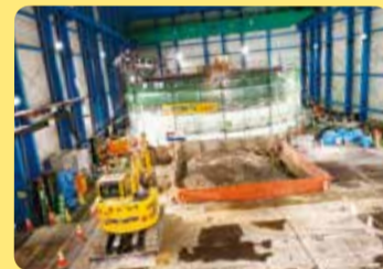
津門川:地下貯留管整備工事の状況(西宮市神祇官町)
