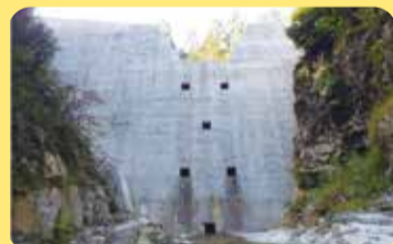
墓ヶ谷川砂防堰堤(西宮市塩瀬町)
