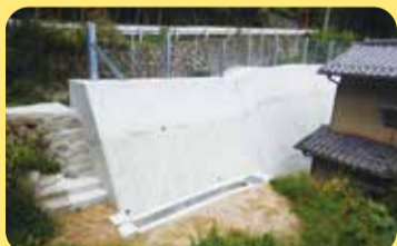
急傾斜地崩壊対策(西宮市山口町)
