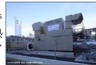
水素コージェネレーションシステム (出典) 川崎重工
