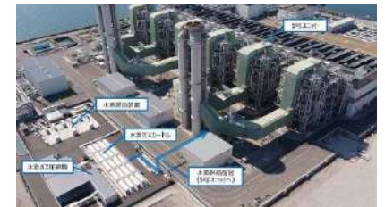
姫路第二発電所(出典) 関西電力
