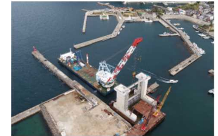
沼島漁港 水門整備
