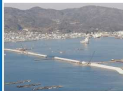
福良港 湾口防波堤
