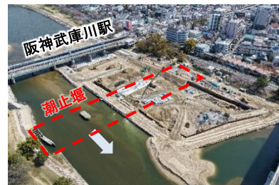
潮止堰撤去工事の状況(R8.4月時点)
