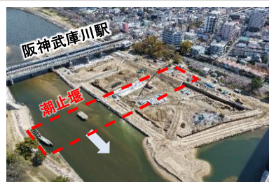
潮止堰撤去工事の状況(R8.4月時点)
