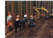
現場実習による即戦力の養成
