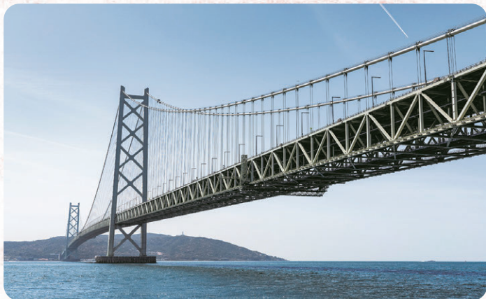
明石海峡大橋
