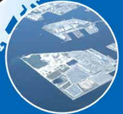
泉大津沖埋立処分場
