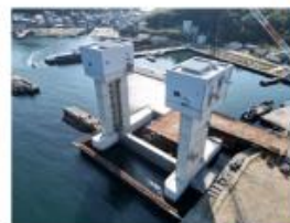
沼島漁港 水門（南あわじ市）
