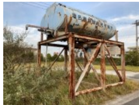
<B 津名港（志筑地区）設置物>
