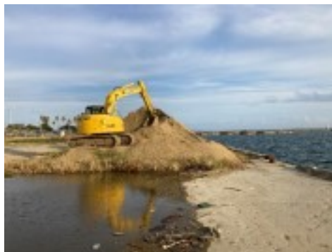
<津名港（志筑地区：生穂）エプロン①>
