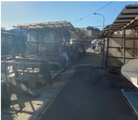
< A 坂越港大黒地区岸壁 >
