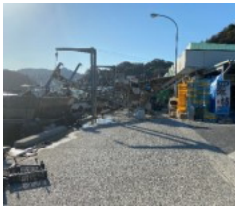
< B 坂越港大黒地区岸壁 >
