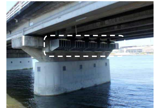
国道250号 汐見橋 落橋防止装置・橋脚補強 (姫路市)
