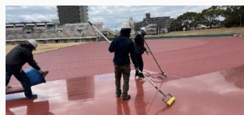
舗装改修状況(R5年度)
