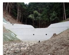
治山ダムの整備
