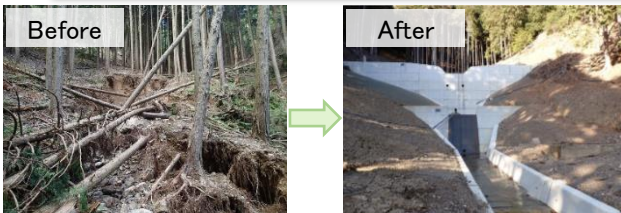
治山ダムの整備 (丹波市春日町稲塚地区)
