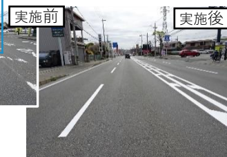
道路区画線の引き直し (宝塚市)
