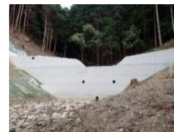
治山ダムの整備
