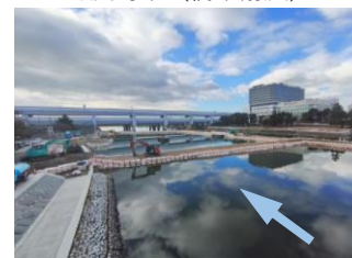
武庫川 河川改修(潮止堰撤去)
