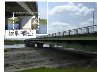
国道250号 播州大橋 地震対策 (橋梁耐震)
