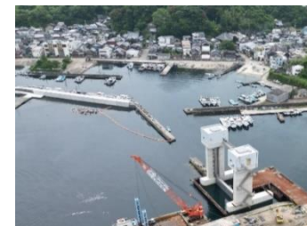
漁港津波対策(水門等整備)
