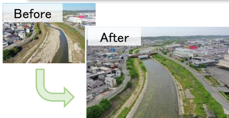
明石川(神戸市) 堆積土砂撤去
