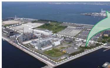
兵庫東流域下水汚泥広域処理場
