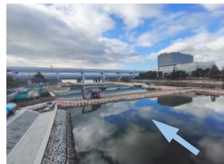
武庫川 河川改修(潮止堰撤去)
