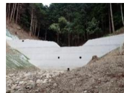
治山ダムの整備
