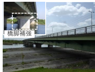
国道250号 播州大橋 地震対策 (橋梁耐震)
