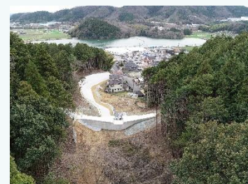
砂防堰堤の整備（兵庫県）
