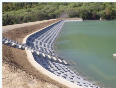
大谷池改修(姫路市)
