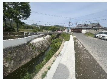
今出川護岸改修事業(淡路市)
