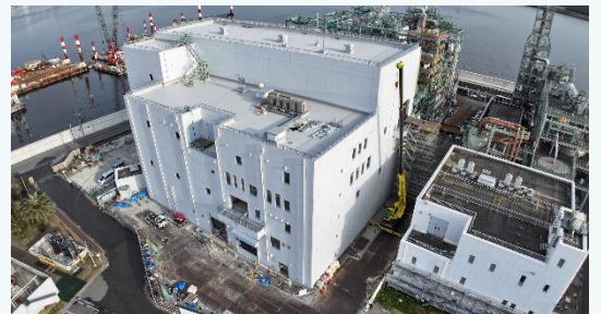
兵庫東流域下水汚泥広域処理場(兵庫県)
