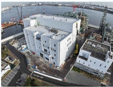
兵庫東流域下水汚泥広域処理場の整備
