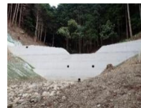
治山ダムの整備
