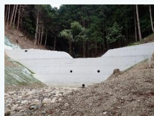
治山ダムの整備(兵庫県)
