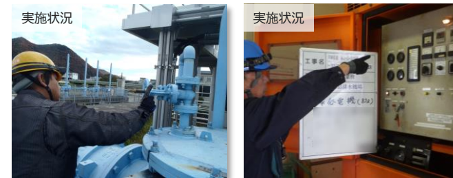
□ 排水機場の定期点検
