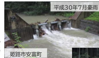
□ 治山ダムによる流木捕捉事例
