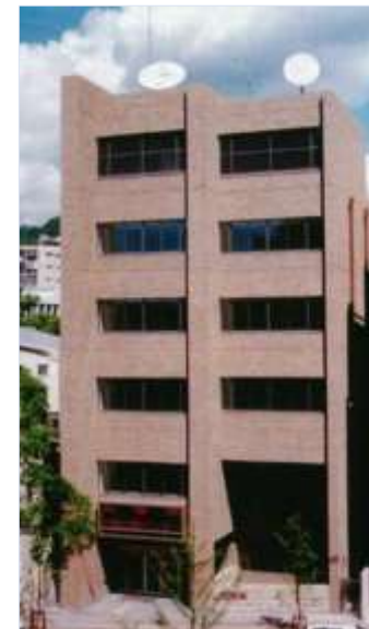
県災害対策センター
