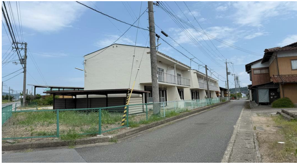
② 全体図(東方より)
