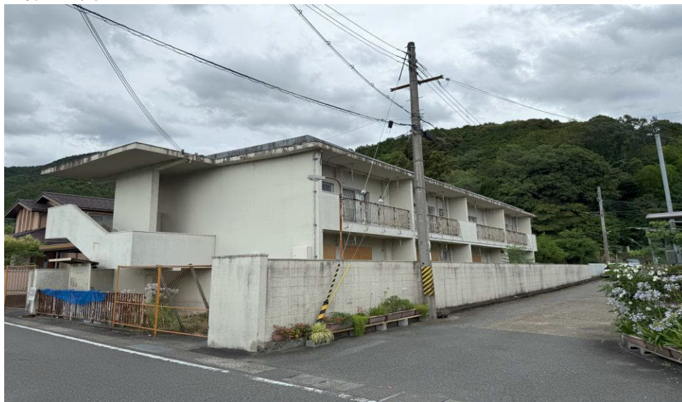
② 全体図(北西方より)
