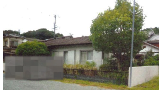
(全景3) 南側から北向きに撮影
