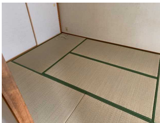
<空き部屋(和室)>
