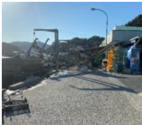
< B 坂越港大黒地区岸壁 >
