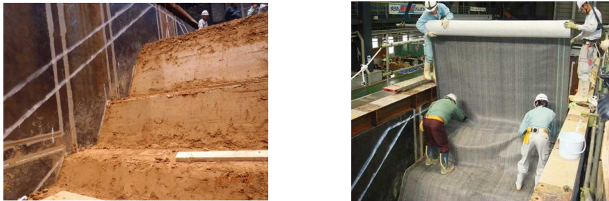
図7 階段状に遮水シート（1枚もの）を施工
