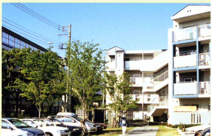
騒音対策と日照を配慮した国道43号沿いの若宮町住宅3号棟
