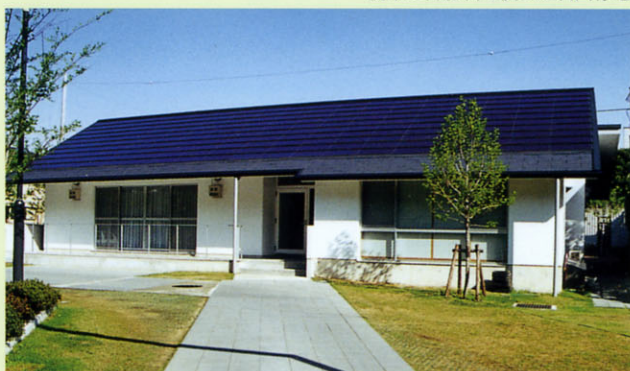
太陽熱・雨水利用も行っている若宮町集会所
