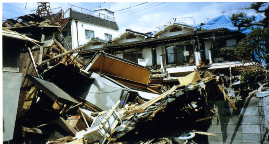
●阪神・淡路大震災の被災状況
