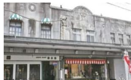
大開通り商店街のまちなみ
