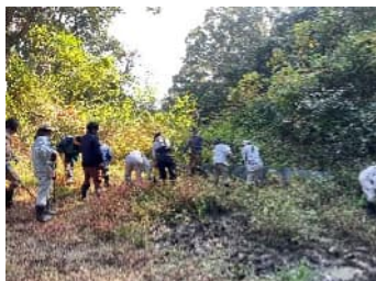
ため池の修復 (あわじ石の寝屋緑地)
