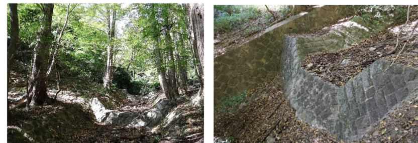
治山遺構施設（S13災害復旧）
