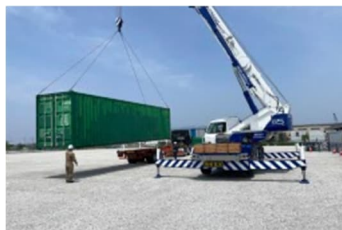
▲強風対策(コンテナ設置)
